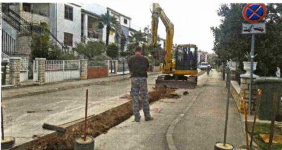
Radovi će se nastaviti u Brionskoj ulici
